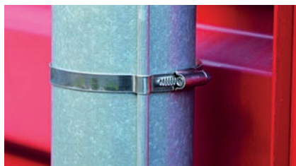
Vedenie zvidomu bleskozvodu uchytené o odkvapovú rúru vyhovujúce STN EN 62305-3.
