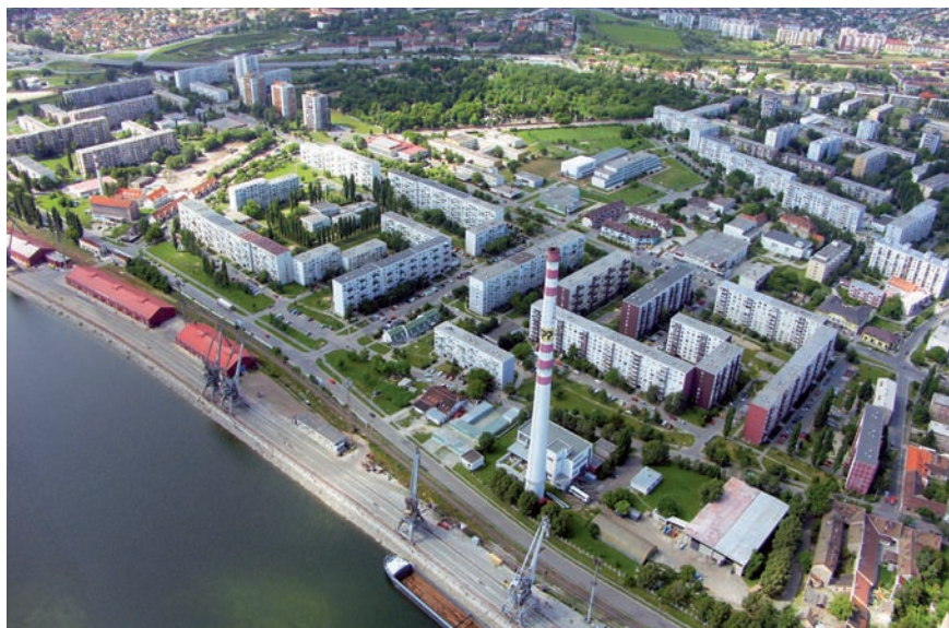
Pohľad na tepelný zdroj COM-therm v Komárne
